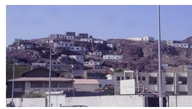
الشكل (11) يوضح البناء على المنحدرات الجبلية غير الامنة التواهي [1]
