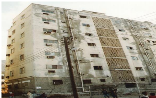
الشكل (5) يوضح غياب الصيانة الدورية في المباني - المعلا عدن [1]
