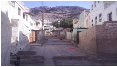
الشكل (9) يوضح البناء على المنحدرات الجبلية بعد الرصف بالأحجار- كريتر عدن *
