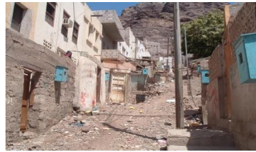
الشكل (10) يوضح البناء على المنحدرات الجبلية قبل الرصف بالأحجار- كريتر عدن
